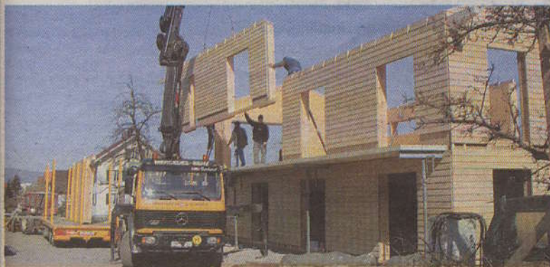
Die Firma hat begonnen, Holzhäuser im Elementbauweise zu fertigen.
